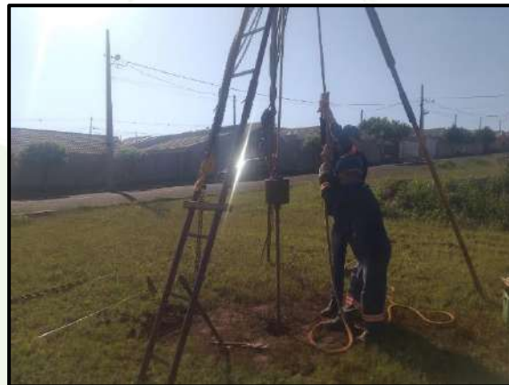
Execução de sondagem SPT
