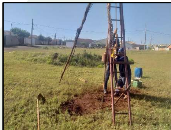
Execução de sondagem SPT
