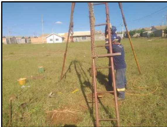
Execução de sondagem SPT
